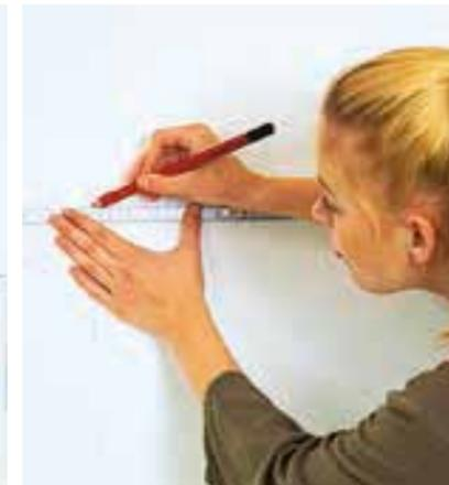
→ **Vor dem Tapezieren** die Wand genau ausmessen und die Ansatzpunkte für die Bahnen mit Bleistift markieren
