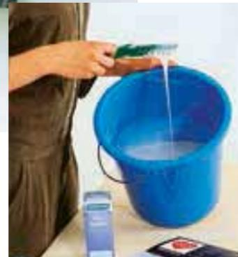
→ **Zum Kleistern** speziellen Vlieskleister anrühren. Mit der Lammfellrolle Bahn für Bahn auf die trockene Wand auftragen
