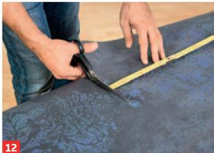
**12** Gelangen Sie mit einer Bahn nicht exakt in eine Tür, längen Sie die Bahn zunächst in kompletter Wandhöhe ab (plus 5 cm).
