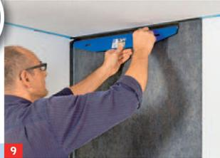
**9** Die Überstände entlang eines Tapezier-spachtels mit einem Cutter abtrennen.
