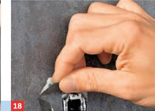
**18** Zunächst die Sicherung ausschalten! Dann mit den Fingern die Stellen ertasten und mit dem Cutter exakt freischneiden.
